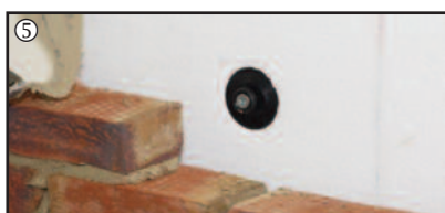
Verblendstein ungehindert setzen.
