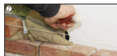
Verblenderhaken einmörteln
